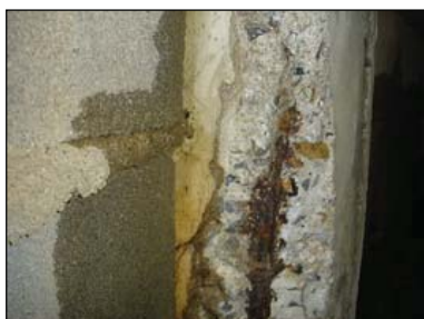
ภาพที่ 1 ความเสียหายของโครงสร้างตอม่อโดยทั่วไป บริเวณหอพักนิสิต
