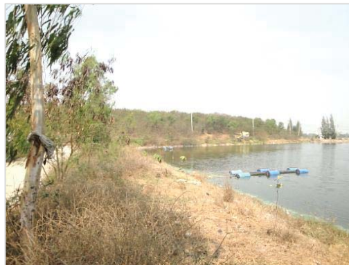
ภาพที่ 1 บ่อเก็บกักน้ำชะมูลฝอย ณ พื้นที่กำจัดมูลฝอย
