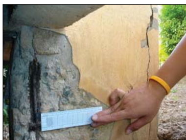
ภาพที่ 1 ความเสียหายของโครงสร้างตอม่อโดยทั่วไป บริเวณหอพักนิสิต
