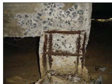
ภาพที่ 1 ความเสียหายของโครงสร้างตอม่อโดยทั่วไป บริเวณหอพักนิสิต
