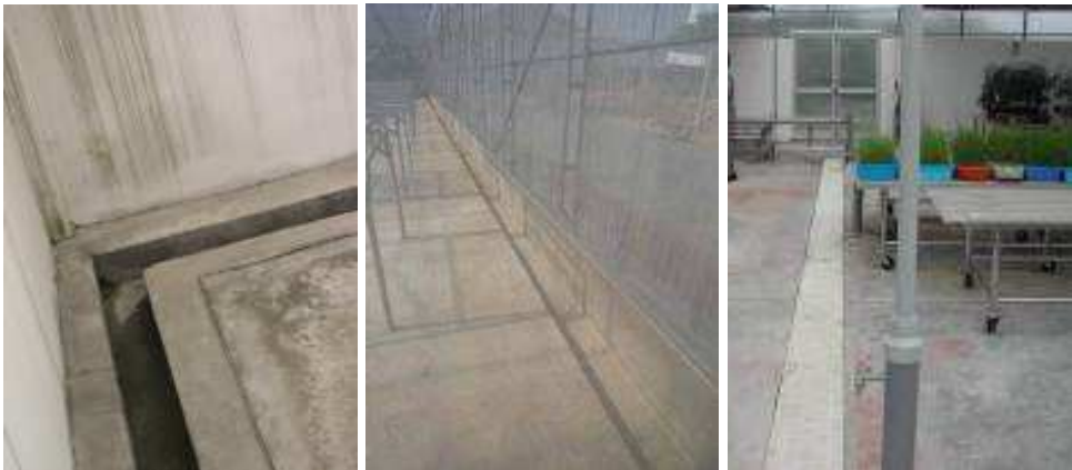
รูปที่ 16 ระบบระบายน้ำภายในโรงเรือน
