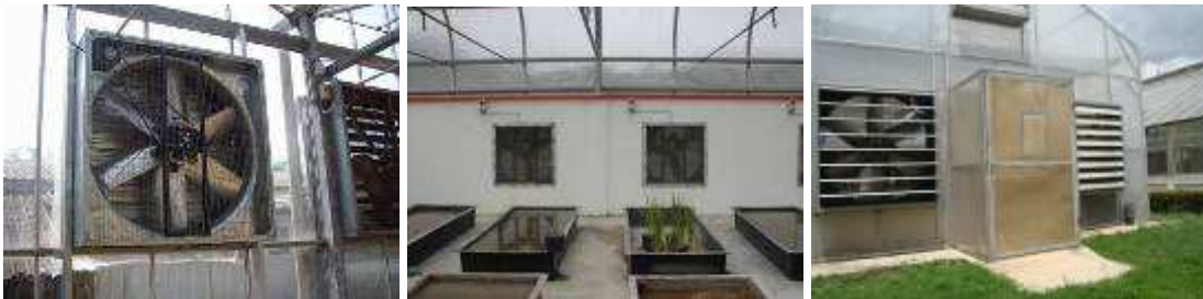
รูปที่ 10 พัดลมระบายอากาศแบบมีบานเกล็ดปิด
