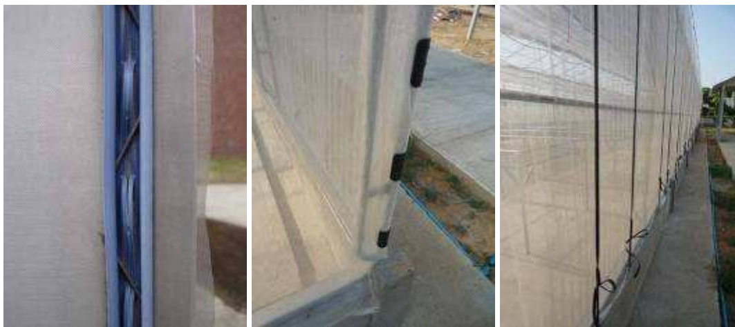
รูปที่ 2 การยึดตาข่ายในลักษณะต่างๆ
