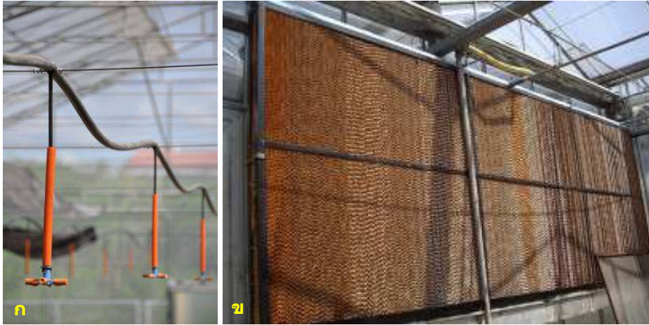
รูปที่ 27 ระบบฉีดพ่นน้ำ (ก) และแผงไอน้ำที่ใช้ร่วมกับพัดลมระบายอากาศ (ข)
