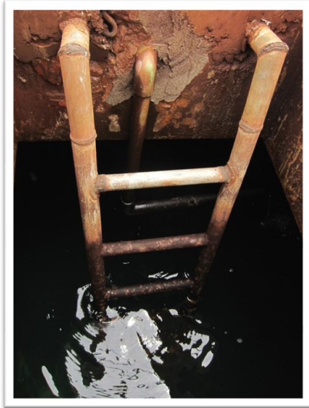
รูปที่ 9 ถังน้ำใสและช่อง man-hole สำหรับลงไปปฏิบัติงาน
